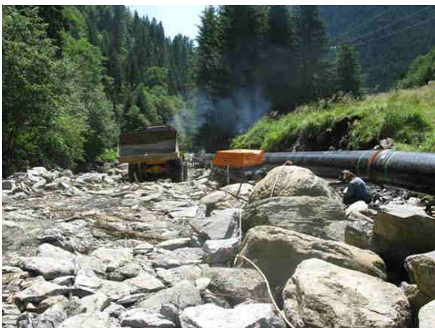
Будівництво малої ГЕС в Румунії. Фото – WWF Romania
